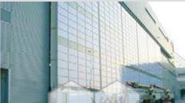
Международный аэропорт, Гонконг (вертикальное остекление). Применялся 12 мм лист монолитного поликарбоната прозрачного и молочного цвета
