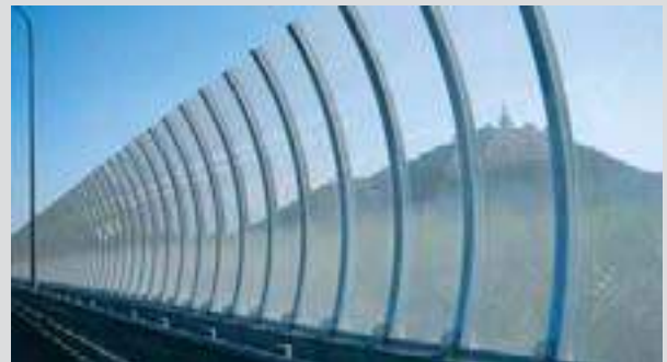
Защитное ограждение автодороги в городе Пекин. Применялся 6 мм прозрачный лист монолитного поликарбоната.
